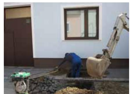
dauerhaft beheben. Dabei wurde das letzte Teilstück zwischen Putzschart im Bereich Fam. Jungmann und Sammelschart Löschteich mit einem PVC-Rohr DN 300 verbunden.
